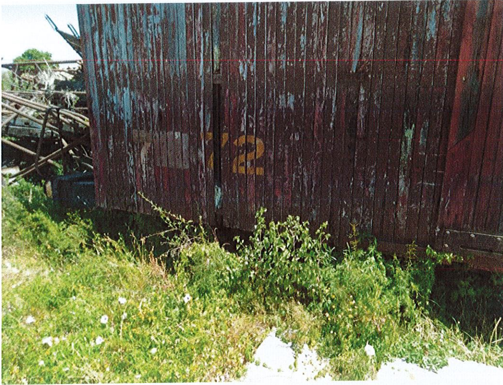
ITEM 17 Cubierto de madera
